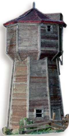
DVVJ vattentorn i N. Bygge: Kirby Vincent.
